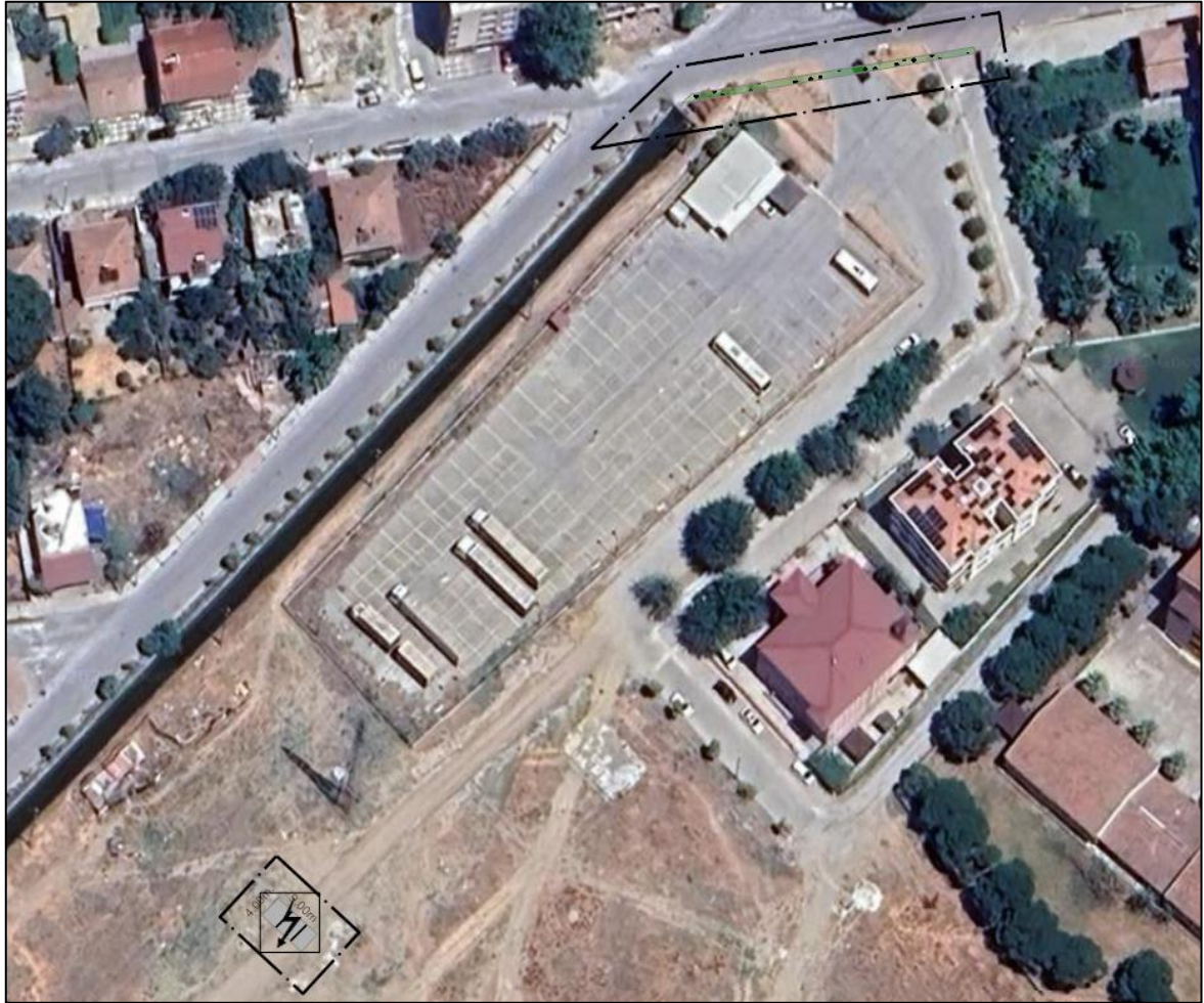
-Trafo Alanının Uydu Görüntüsündeki Konumu-
