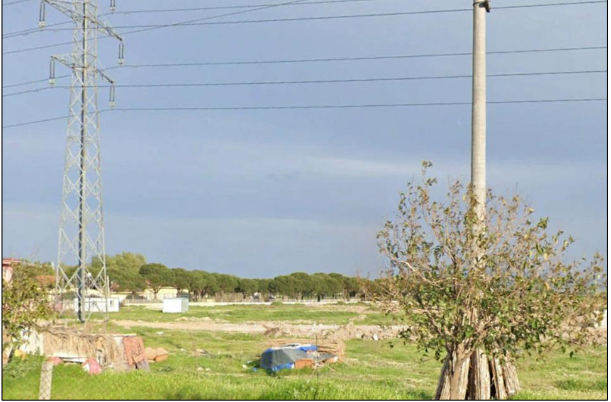
-Trafo Alanından Görüntü-
