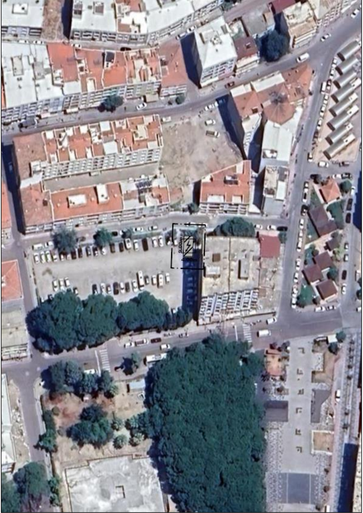
-Trafo Alanının Uydu Görüntüsündeki Konumu-
