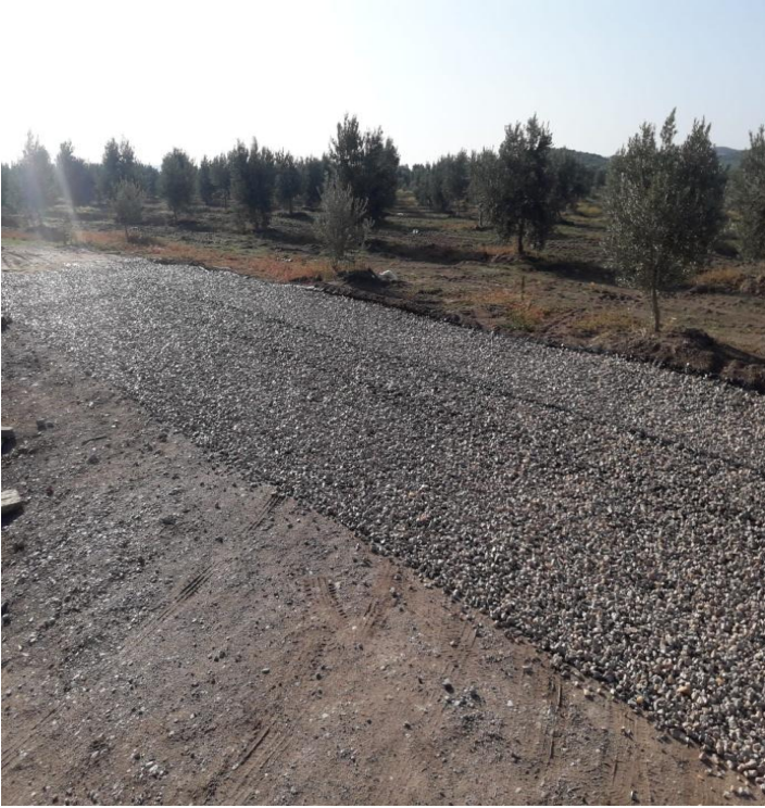
Dilek mahallesindeki; muhtelif yollara kombine sathi kaplama aracı ile kaplama çalışması yapılmıştır.
