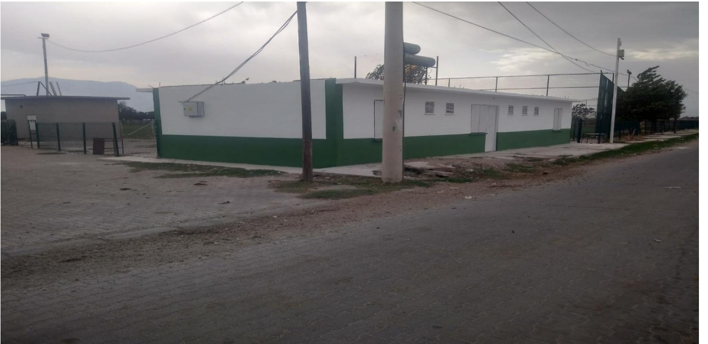
Eski görünüm Yeni Görünüm
