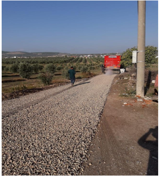
Dilek mahallesindeki; muhtelif yollara kombine sathi kaplama aracı ile kaplama çalışması yapılmıştır.
